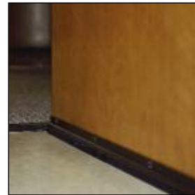
Door Bottom Installation
