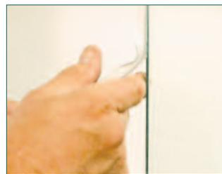
Entfernen Sie die beschädigten oder spröde Wasserdichtung oder Abstreifer.
