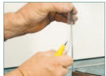
Schneiden Sie die neue passende Dichtung zur selben Länge wie die Originale und installieren sie.
