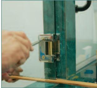
Lösen Sie die Abdeckplatte und justieren die Tür.
