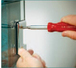
Nach der Ausrichtung, ziehen Sie die Schrauben bei Hand an. Verwenden Sie kein Elektrowerkzeug, Sie riskieren damit die Schraubenköpfe zu beschädigen.
