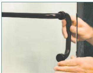
Installieren Sie die neuen Griffe oder Knöpfe und befestigen Unterlegscheiben und Schrauben.
